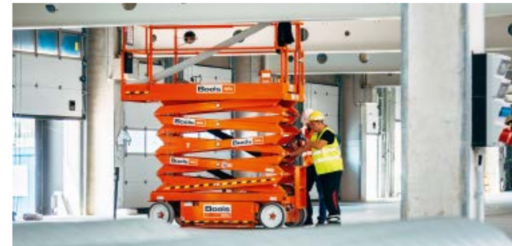
» Wenn der HANSA-FLEX Monteur am Einsatzort eintrifft, verlässt sich Boels komplett auf ihn. Nur er begutachtet den Schaden. » When the HANSA-FLEX technician arrives on the scene, Boels relies completely on him. He alone assesses the damage.
