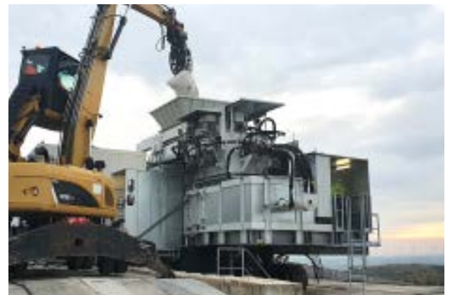
Zwei-Wege-Presse bei der IAG – Ihlenberger Abfallentsorgungsgesellschaft mbH, Selmsdorf.
