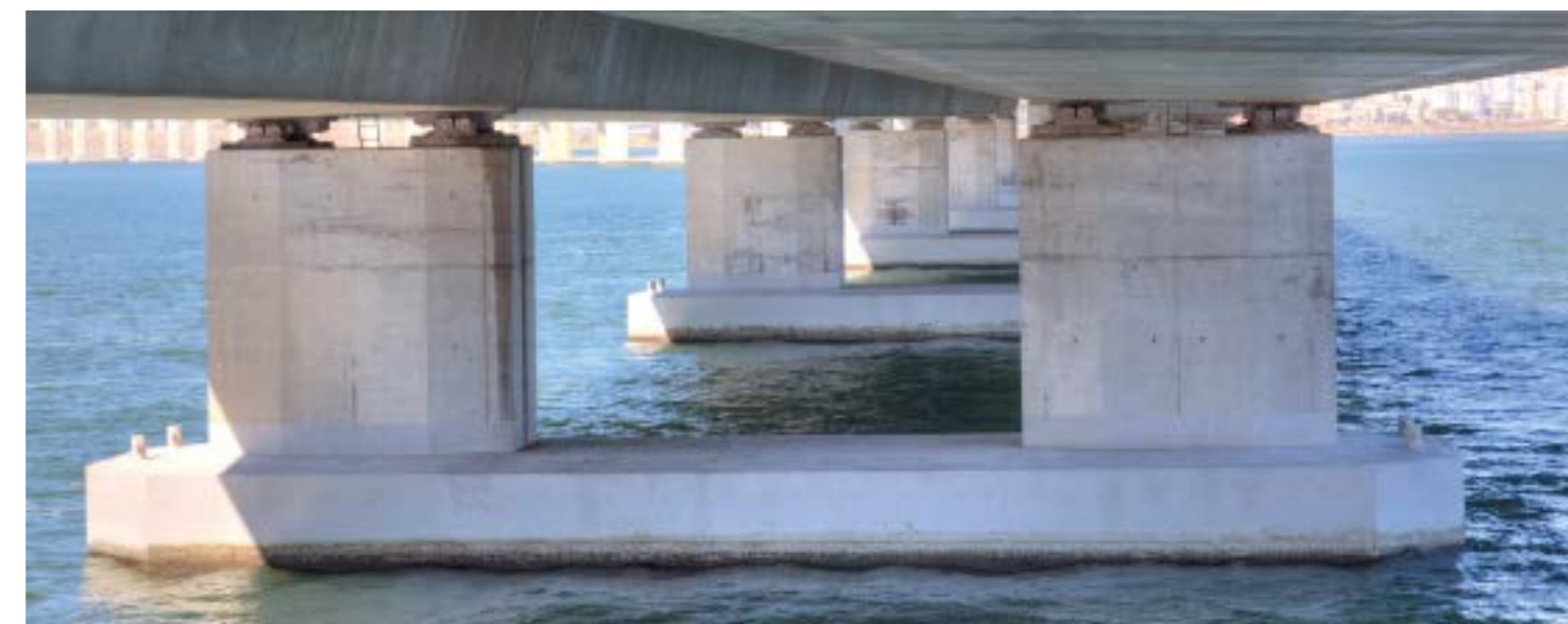
Die Vasco-da-Gama-Brücke ist mit 17,2 km die längste Brücke in Europa. Hydraulische Dämpfer spielen eine zentrale Rolle dabei, die Brücke vor Erdbeben zu schützen. With a length of 17.2 km the Vasco da Gama Bridge is the longest bridge in Europe. Hydraulic shock absorbers play a central role in protecting the bridge against earthquakes.
