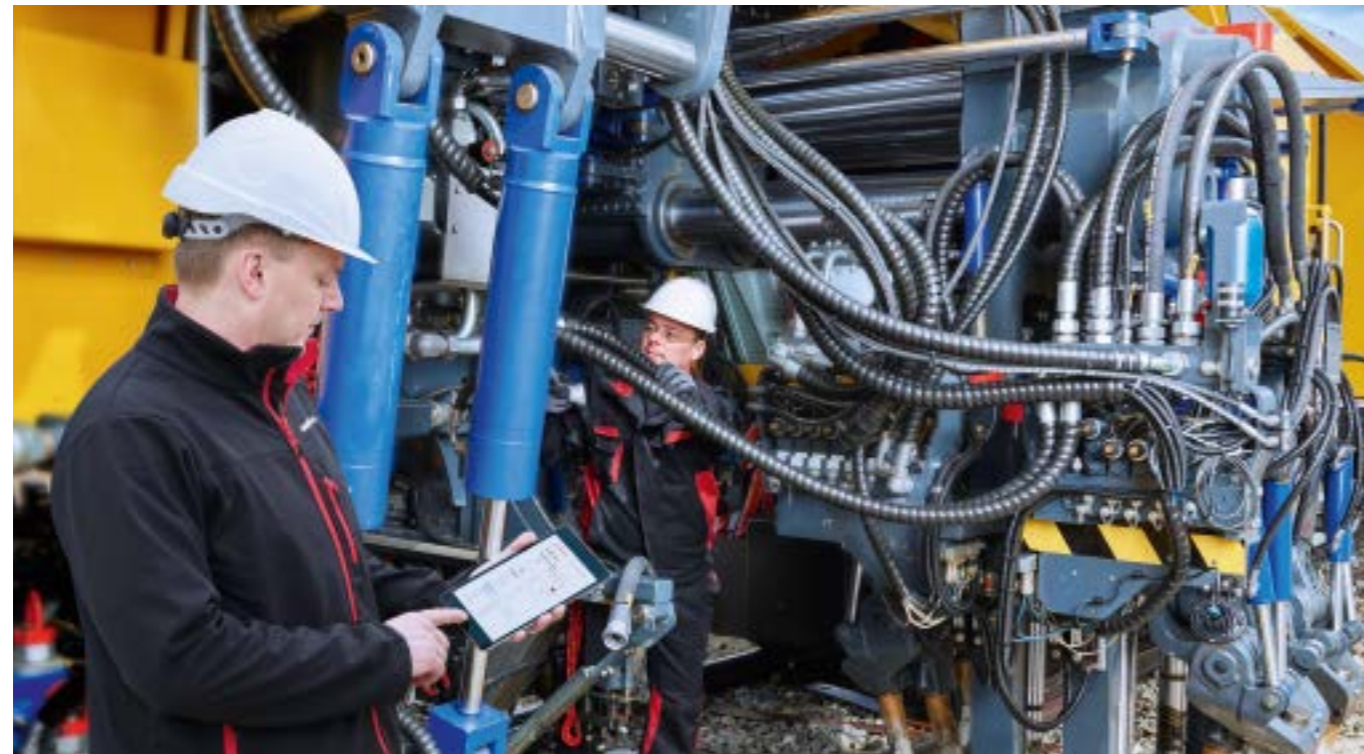
Instandhalter können zielgenau die passenden Schlauchmanagementleistungen für den sicheren und rechtssicheren Betrieb ihrer Anlagen wählen. Maintenance engineers can select precisely the right hose management services for the safe and legally compliant operation of their systems.
